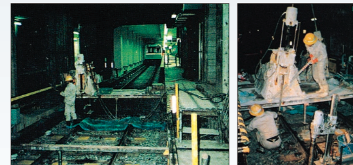
駅構内施工状況
