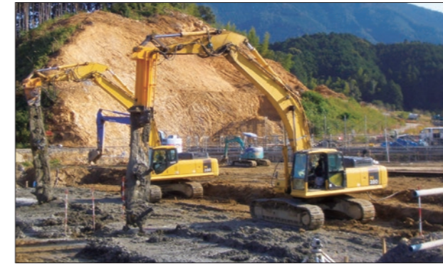
スラリー施工
