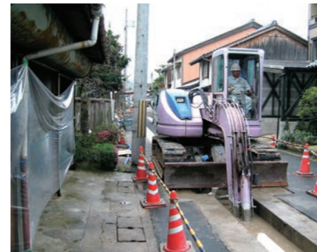
管路掘削状況
