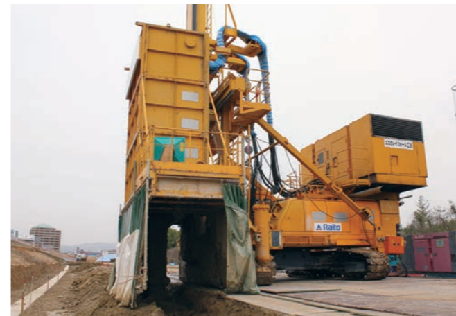
大型等厚式施工機での施工状況
