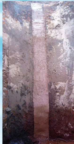
壁掘削断面 (t=700mm)
