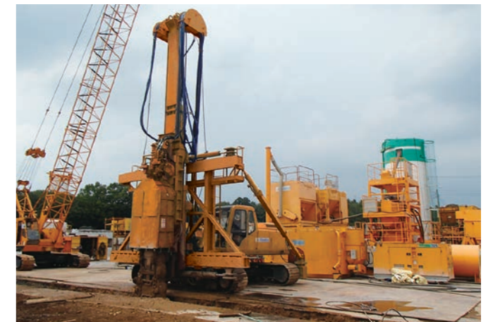
小型等厚式施工機での施工状況
