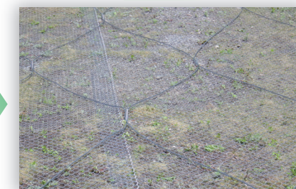
ケーブル設置
