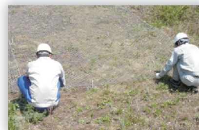
エクシードネット設置
