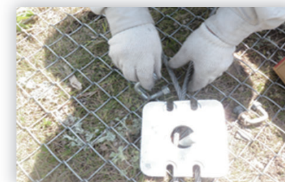
DCプレート設置
