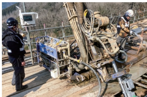
削孔角度方位計測状況
