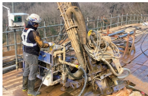
削孔長計測状況
