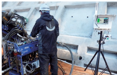
削孔長計測状況
