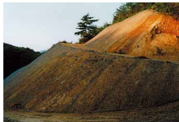
吹付前（金網張工完了）
