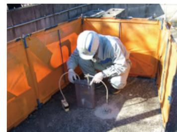
表層土壌、土壌ガス等の平面的な汚染状況調査の結果をもとに、深さ方向の汚染状況を調査します。
