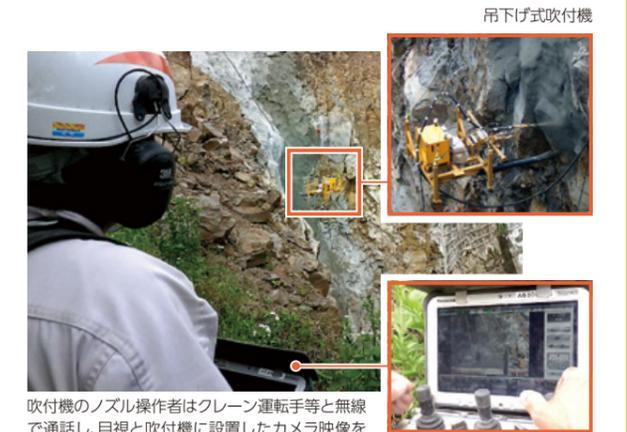
吹付機のノズル操作者はクレーン運転手等と無線で通話し、目視と吹付機に設置したカメラ映像を確認しながら、安全な場所での操作が可能
