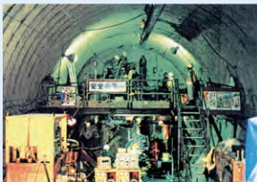
1995 北越北線鍋立山トンネル注入工事
