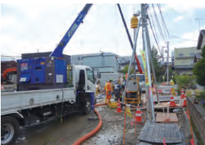
Megaジェット工法を用いて流動化を防止
