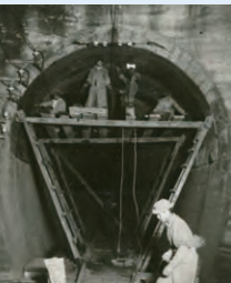
1943 トンネル防水工事
