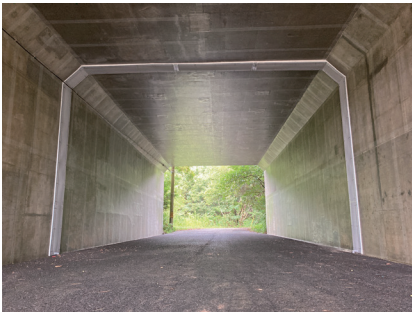
令和4年度 主要県道山口宇部線(阿知須1号ボックスカルバートほか)道路付属物(長寿命化メンテ修繕)補正工事第1工区 (株)山口リアライズ
