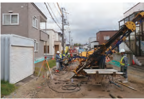
浸透固化処理工法で住宅下部を 地盤改良
