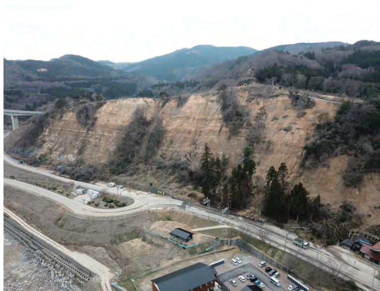
国道249号線被害箇所 当初の様子
