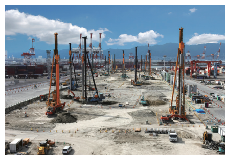
神戸ポートアイランド（第2期）地区荷さばき地（PC15～17）地盤改良工事
