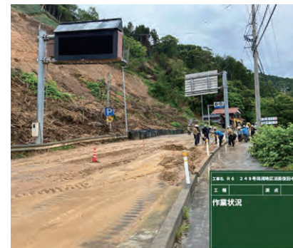
周辺の沢から流出した土砂を清掃する様子
