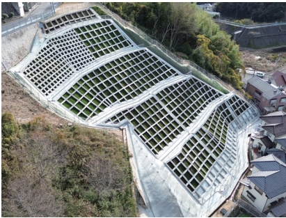
安東三丁目12地区急傾斜地崩壊対策工事 サンヨー緑化産業(株)
