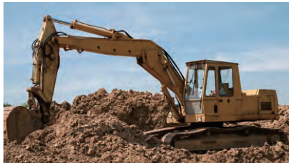
一般土木・その他工事
