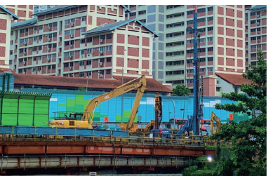
ノースサウスコリドー N109A区 地盤改良工事(シンガポール)
