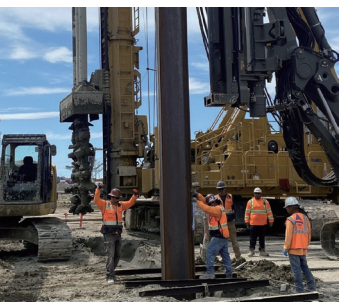
オークランド港 セブンストリート地区 山留壁工事(米国)
