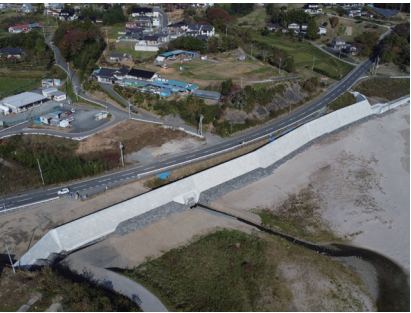
日門漁港日門防潮堤工事(その2) (株)小野良組
