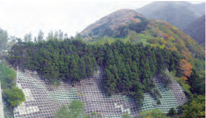
斜面・のり面対策工事
