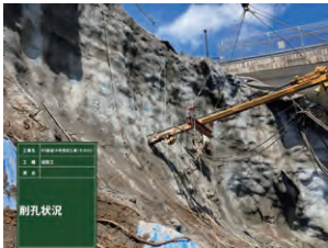
吊下げ式スカイドリルによる ロックボルト工
