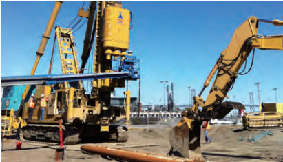
基礎・地盤改良工事
