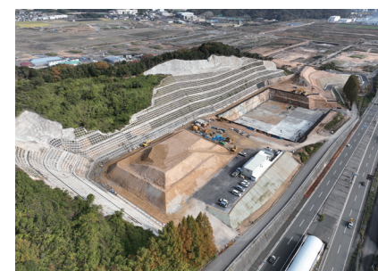
敦賀市一般廃棄物最終処分場建設工事（土木）における法面保護工事
