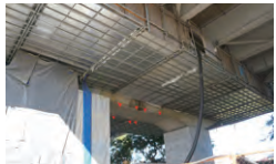
支承取替作業足場
