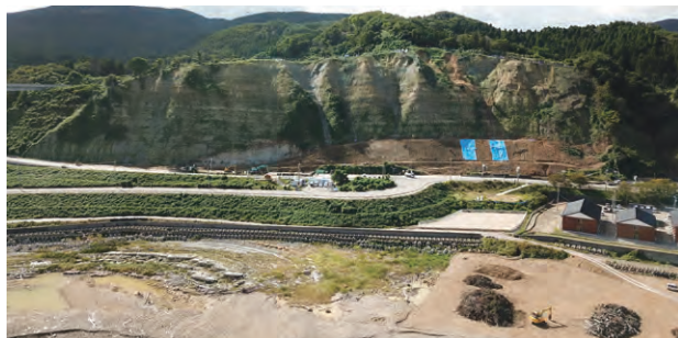
R6 249号珠洲地区法面復旧その1工事
