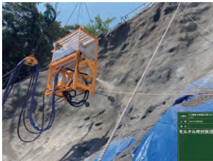
Robo-Shot Type-Gによるモルタル吹付
