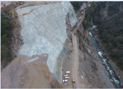
2017 長陽大橋ルート復旧工事
