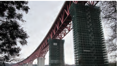
補修・補強工事
