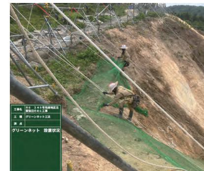
仮設の落石防止ネット敷設
