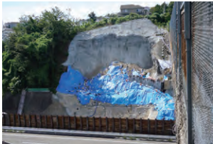
仮復旧施工中
