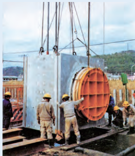
1980 「プラス工法」*による横須賀プラス(管沈埋)工事
