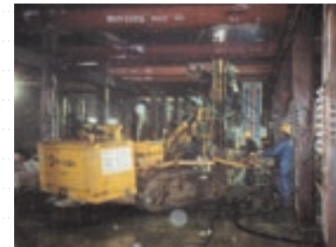
削孔及び建込作業
