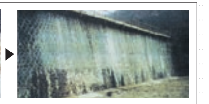
工事後(止水完了)
