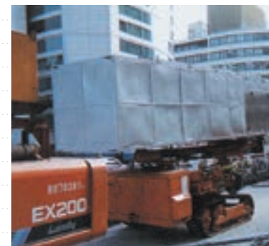
騒音対策(削孔機)
