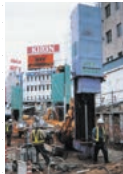
防音型削孔機
