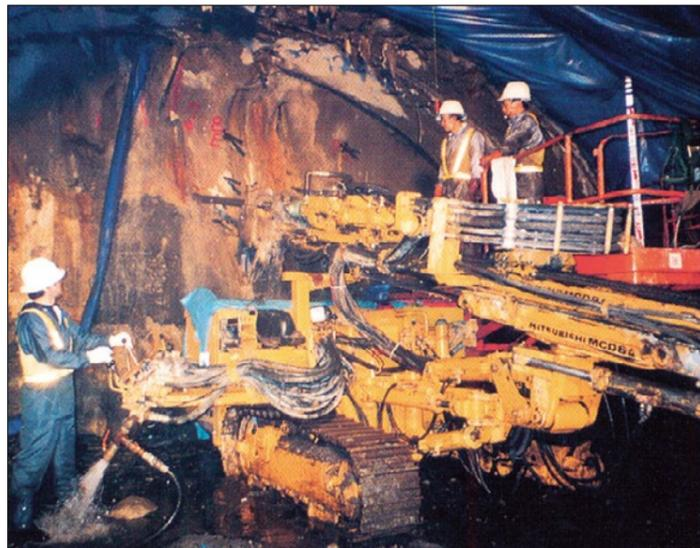
ドリリングマシン（ロータリーパーカッションドリル）による削孔状況
