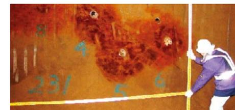
FG工法 (AGF-RL工法による鏡補強)
