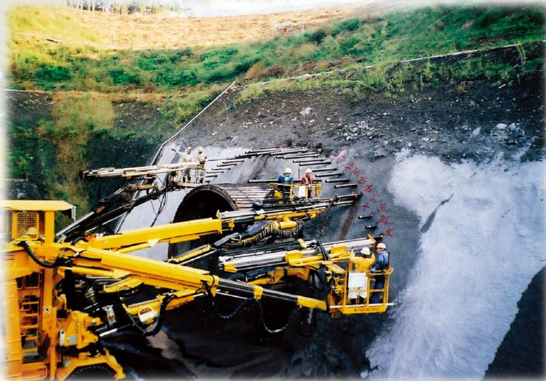
トンネルを掘り進むうえで補助工法を必要とする場合は、地山強度不足によるトンネル掘削断面の変形、または湧水に伴う地山崩壊です。これらの現象に対応すべく目的にあった補助工法を提案いたします。
