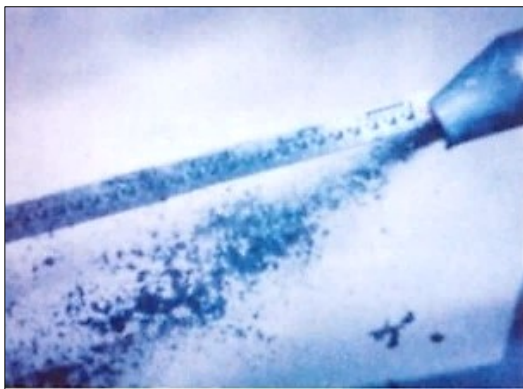
写真-6 エアのみで搬送する吹付け方式
