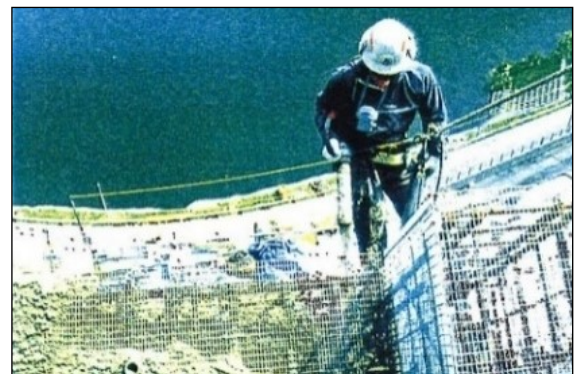
写真-11 打設高さ 100 m のダム工事の施工状況
