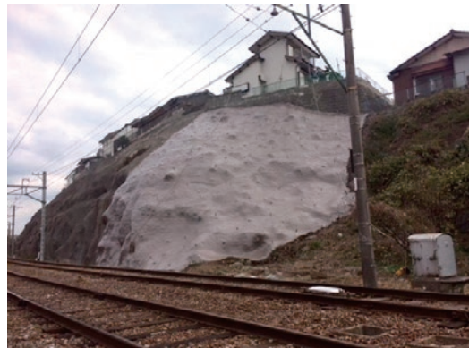
トップコート吹付完了
