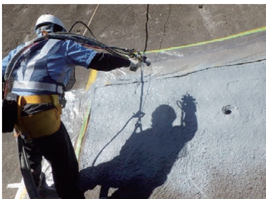
①樹脂吹付状況
