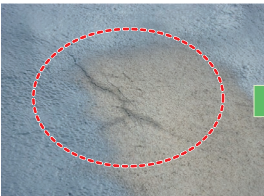
軽微なひび割れ(2.0mm程度)閉塞状況
