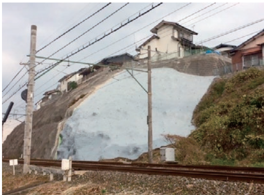
樹脂吹付完了
