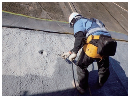
②トップコート吹付状況
