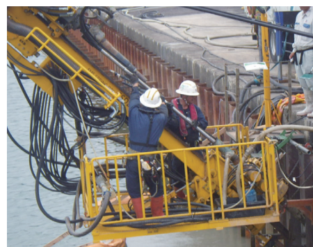
アンカー挿入状況
