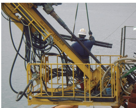
ドリルパイプ脱着状況
