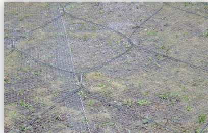
ケーブル設置
