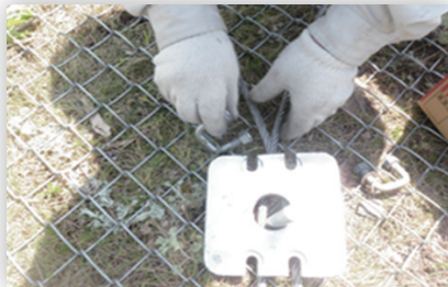
DCプレート設置
