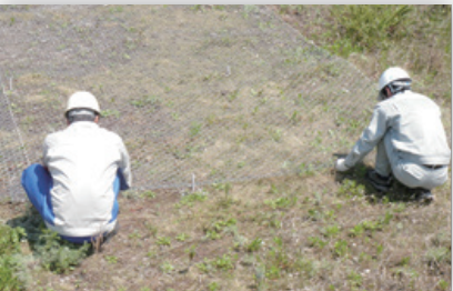
エクシードネット設置
