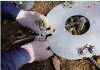
ESプレート設置
