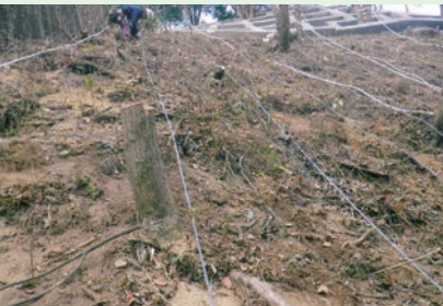
ワイヤケーブル設置
