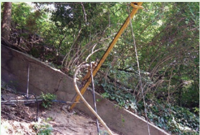
削孔・グラウト注入
