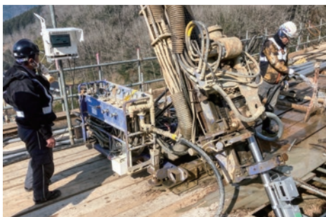
削孔角度方位計測状況
