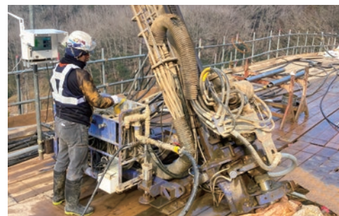
削孔長計測状況
