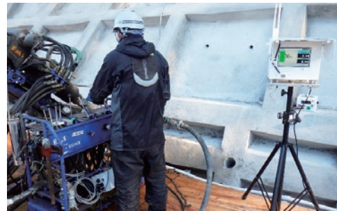
削孔長計測状況
