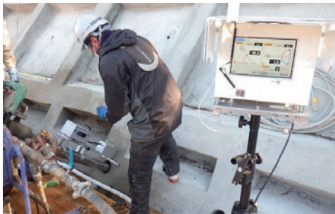
削孔角度方位計測状況
