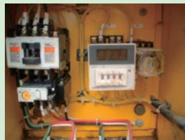
従来型水量計の調整箇所
