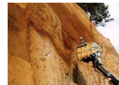
モルタルコンクリート吹付工
