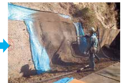
色合い調整工 (吹付工着色試験)
