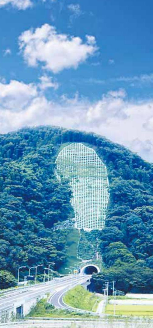
ユニラップ工法は従来のオールエア吹付工法に比べ材料が分離せず塊状に吐出されるため、リバウンドロスが非常に少なくなります。
