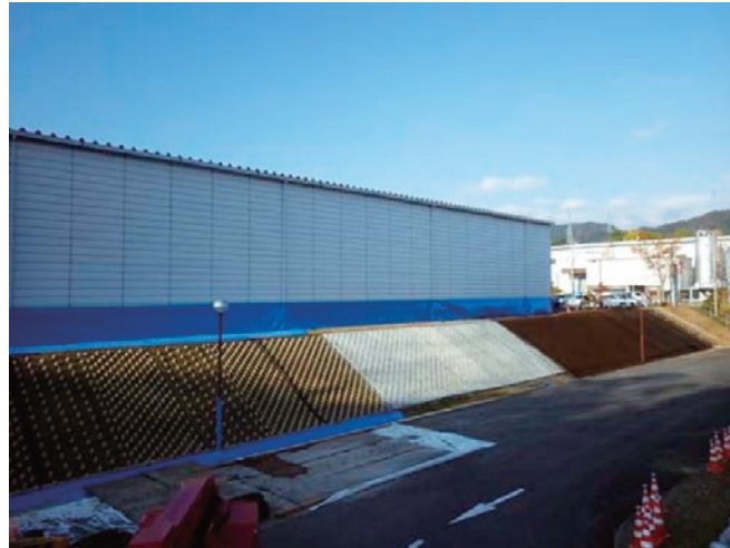
マルチ法面作業全景
