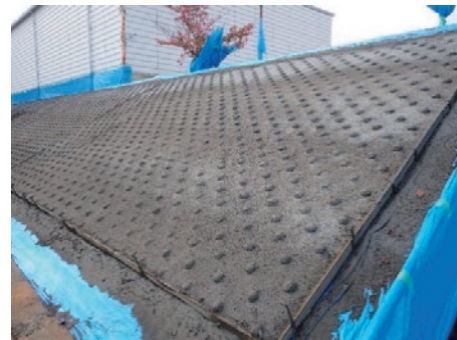
②モルタル吹付工
