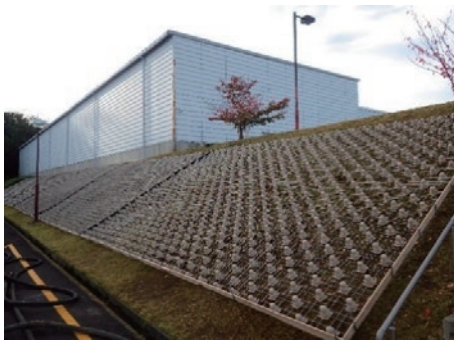
①パルプモールド設置工
