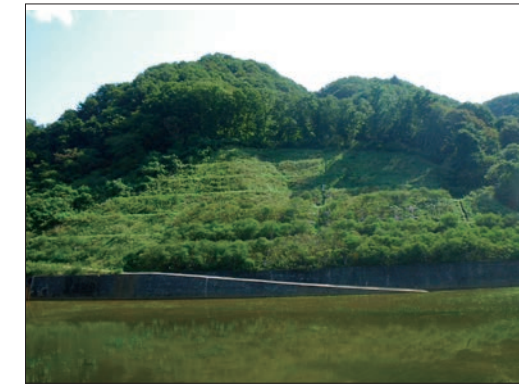
施工前（この後、変状・崩壊発生）
