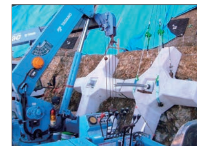
受圧板据付工
