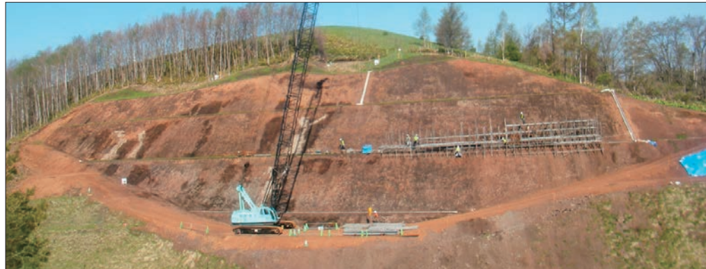
アンカー打設前
