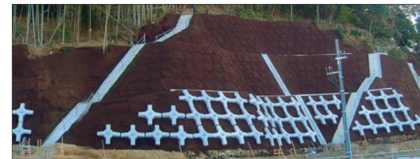
植生基材吹付工 完了
