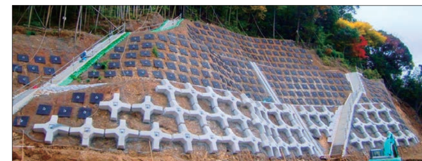
受圧板据付工 完了
