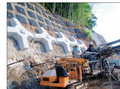
アンカー削孔・注入・挿入工
