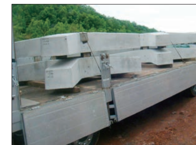
受圧板の搬入
