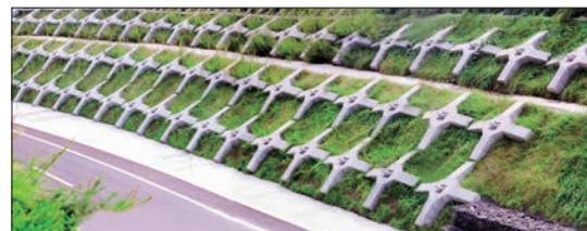
施工完了後のRCクロアブロック
