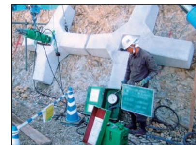
アンカー緊張定着工
