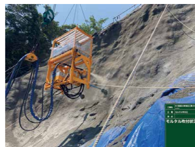
Robo-Shot Type-Gによるモルタル吹付
