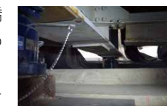
支承接替作業
