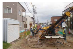
浸透固化処理工法で住宅下部の地盤改良
