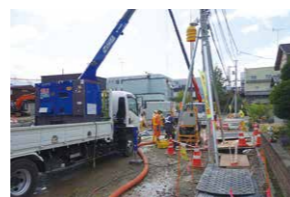
Megaジェット工法を用いて流動化を防止
