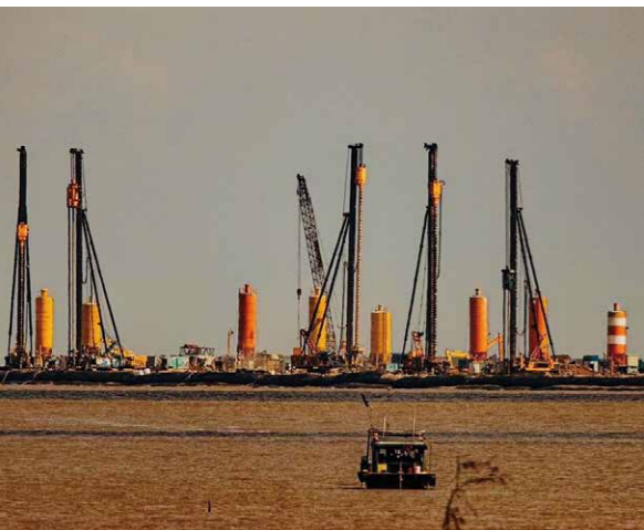
ベトナム ラックフェン5&6 (地盤改良)
