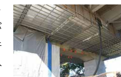
支承接替作業足場
