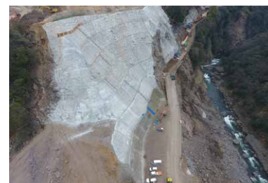
ライト工業は斜面崩壊した阿蘇長陽大橋と戸下大橋(写真)ののり面を含む「長陽大橋ルート」の復旧工事を行った
