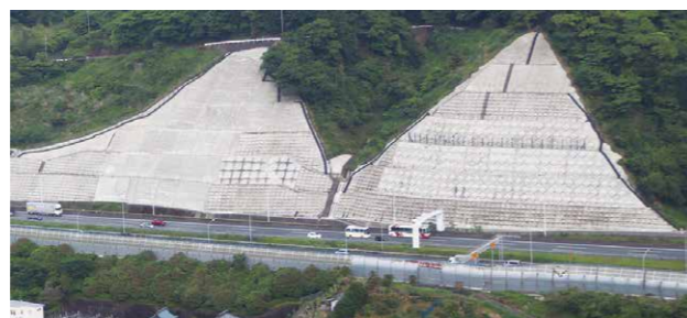
東名高速道路小坂地区 グラウンドアンカー 補修工事
