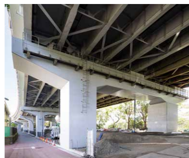
新湘南バイパス 下町屋高架橋北耐震補強工事
