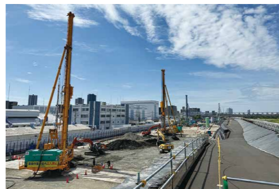
淀川左岸線(2期)トンネル整備工事-2に 伴う地盤改良工事
