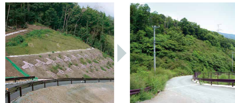
施工から3カ月後
