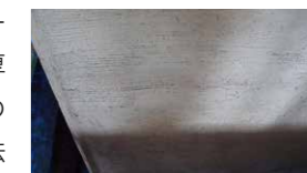
ポリマーセメントモルタル仕上げ面
