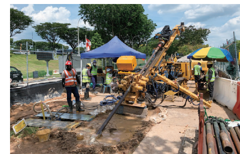
クロスアイランド線CR110埋設防護工事(コンダクションナビ)
