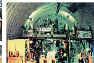
1995 北越北線鍋立山トンネル注入工事
