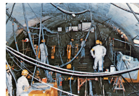
1974 上越新幹線中山トンネル工事の注入作業
