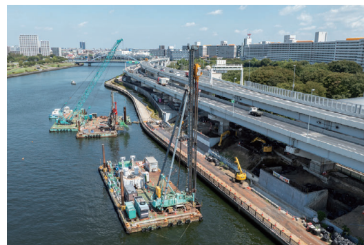
隅田川(白鬚橋上流)左岸防潮堤耐震補強工事
