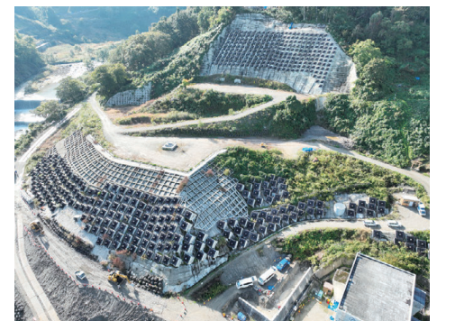
山形県最上郡 土砂災害対策事業(防災安全・地すべり)柳瀬上部斜面对策工事
