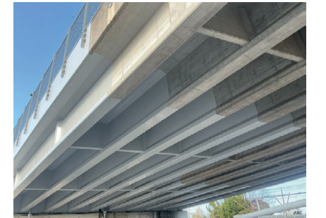
県道宇島港線外1路線 明神跨線橋外1橋橋梁補修工事：(株)九州リアライズ
