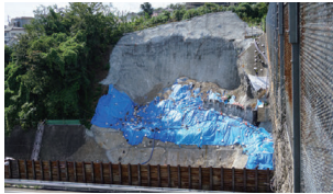
仮復旧施工中
