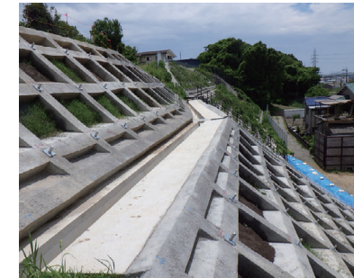
緊急急傾斜地崩壊対策工事：(株)東海リアライズ
