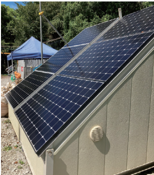
蓄電ユニット組み込み型の太陽光発電装置
