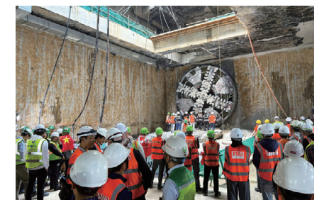
ハノイ地下鉄3号線トンネル・地下駅築造工事(キンマー駅～ハノイ駅間)
