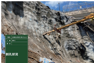
吊下げ式スカイドリルによるロックボルト工
