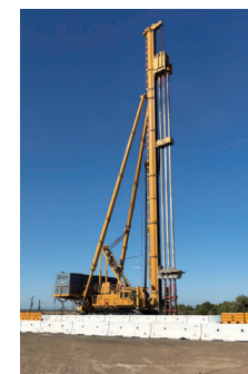
ナトーマス・リーチD地区における堤防改良工事
