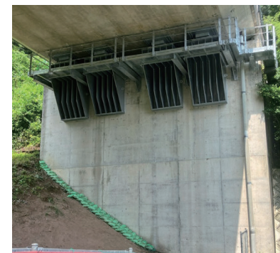
高知自動車道 南国IC～伊野IC間耐震補強Ⅰ工事(その1)
