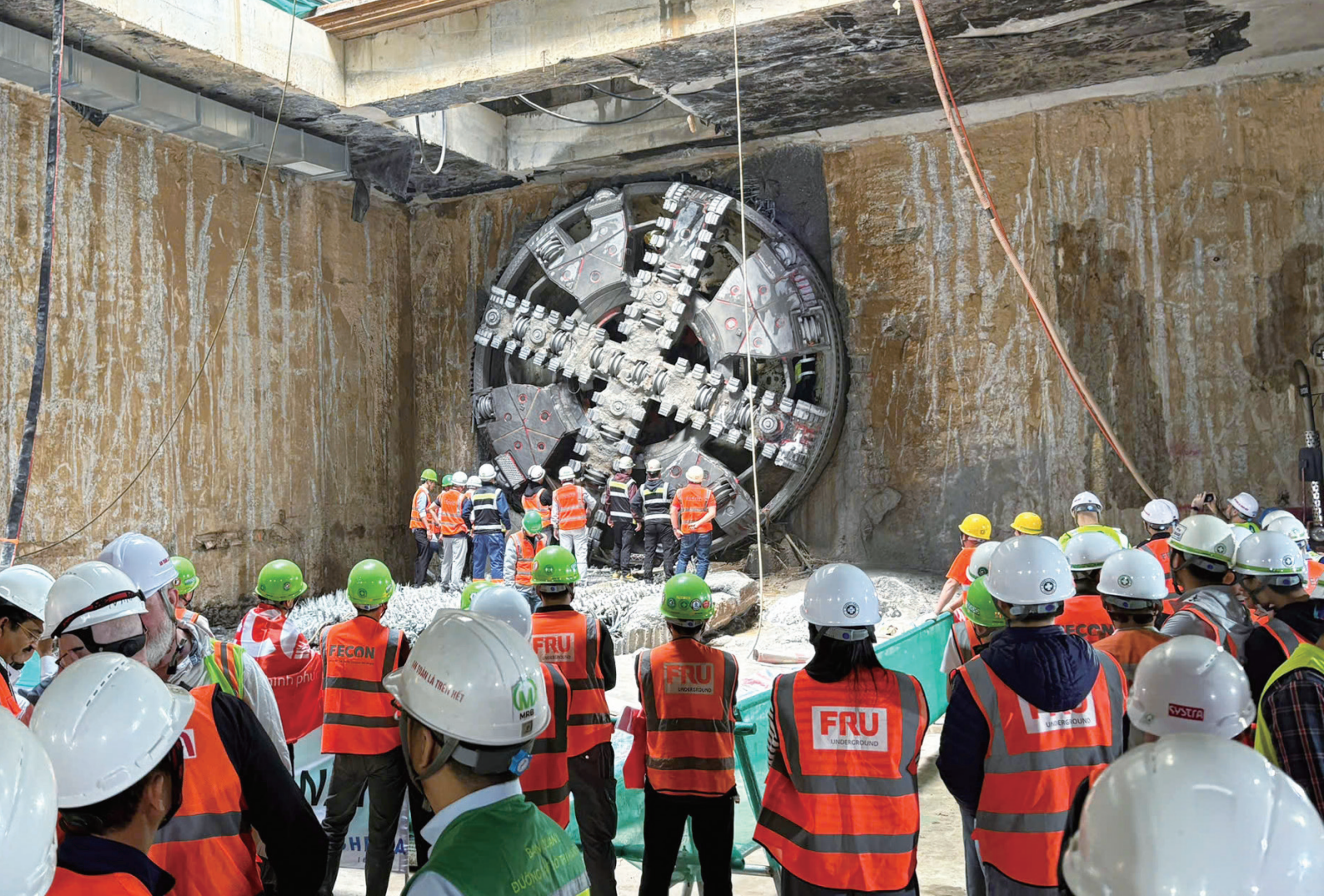
ハノイ地下鉄3号線 トンネル・地下駅築造工事 (キンマー駅～ハノイ駅間)
