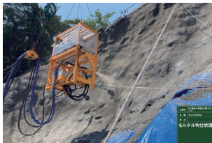
Robo-Shot Type-Gによるモルタル吹付
