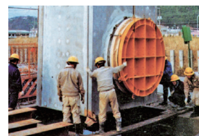
1980 「プラス工法」*による横須賀プラス(管沈埋)工事
