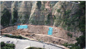
施工中の様子
