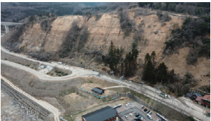
国道249号線被害箇所 当初の様子
