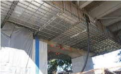
支承取替作業足場
