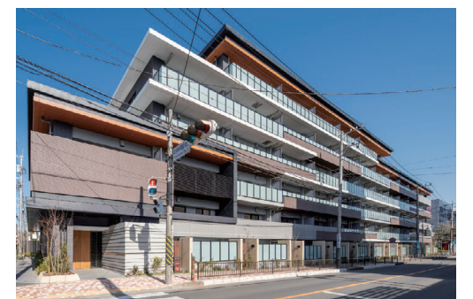
神奈川県大和市中央林間共同住宅
