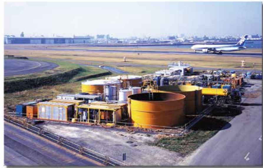
施工実績（東京国際空港） 注入プラント
