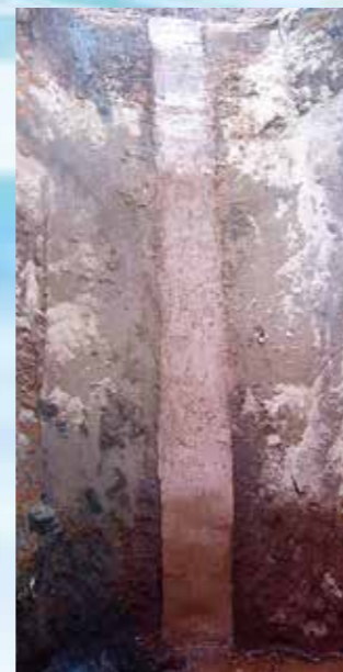
壁掘削断面 (t=700mm)
