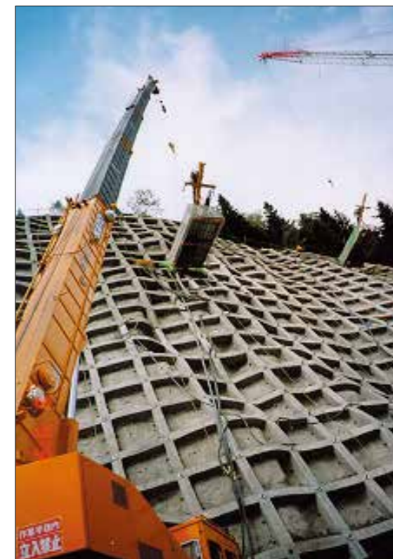
垂直高30m以上の施工状況
