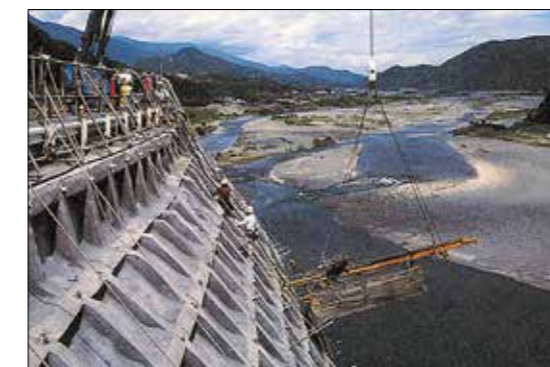
道路下斜面での施工状況
