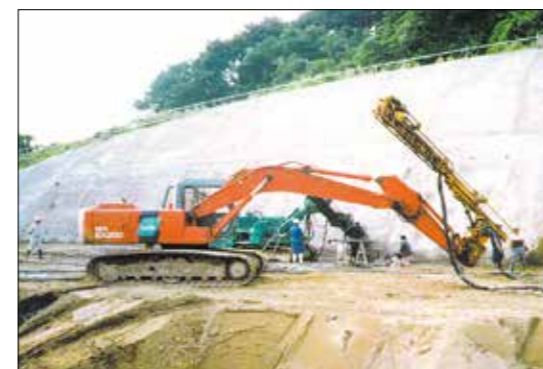
逆巻きでの施工状況
