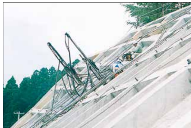
既設法枠上での施工状況
