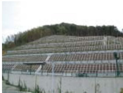
▲ 工事完成 (2002年3月)
