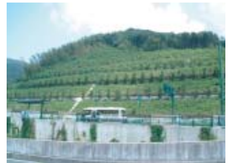
▲ 工事の1年5ヶ月後 (2003年8月)
