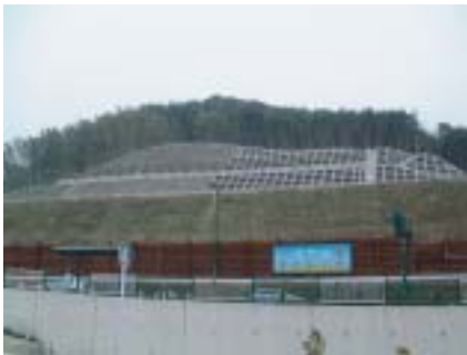
▲ 工事途中 (2001年4月)
