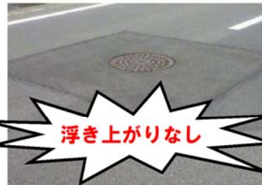
ハットリング工法施工済
