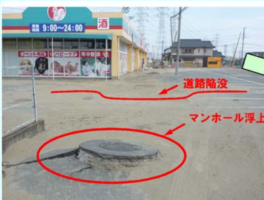
開削工法施工被害路
