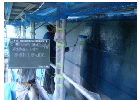
橋脚の炭素繊維シート巻立て状況
