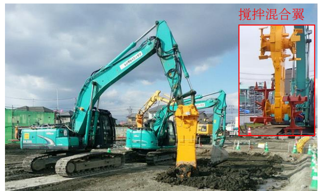
写真2 SCM 工法 施工全景 (表層中層混合処理)
