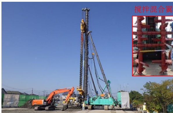
写真1 RMP-MST 工法 施工全景 (深層混合処理)
