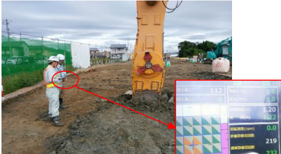
写真5 タブレットによる施工管理 (SCM 工法)
