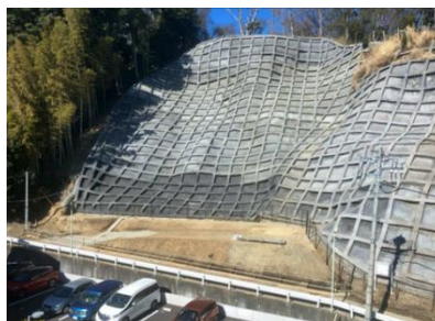
写真 1. 施工完了全景
