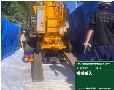
写真7. 機械搬入時のリスク回避 (タイヤ装着)
