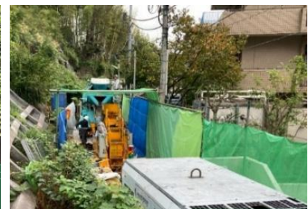
写真6, 7. 周辺施設に近接したプラント配置（養生状況）
